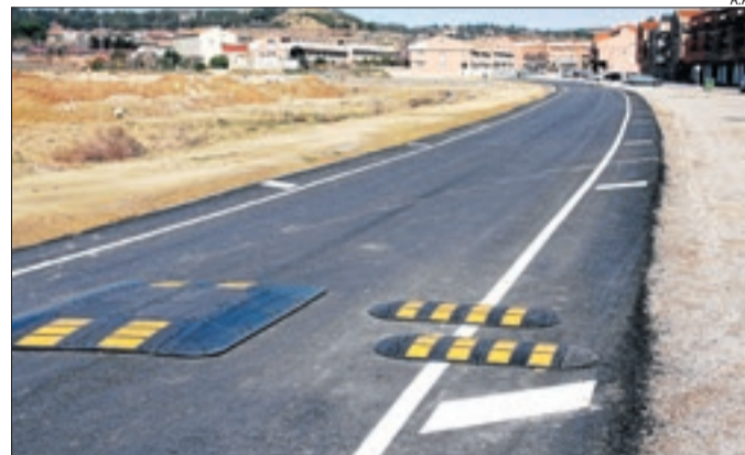
Les obres al vial entre el carrer Raimat i Joaquim Costa.
